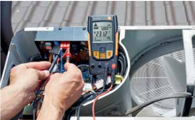
testo 760 ile bir dış soğutma ünitesi üzerinde gerilim ölçümü
