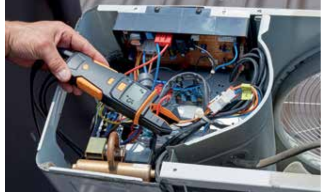
testo 755 ile bir dış soğutma ünitesi üzerinde akım ölçümü
