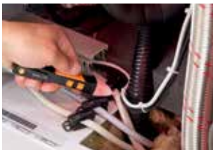
Bir kompresör üzerindeki gerilim kaynağının ilk testi
