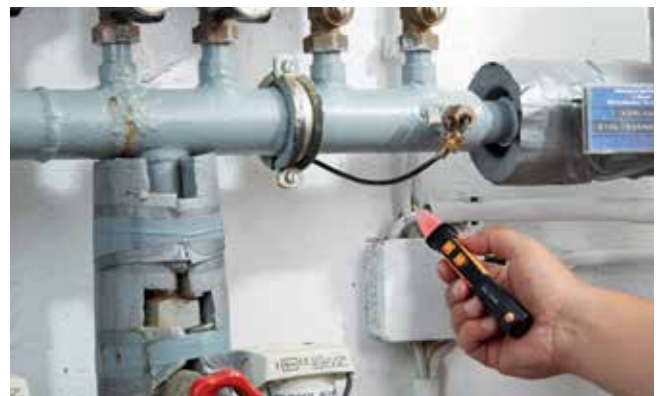
testo 745 ile bir tevzi kutusu üzerinde gerilim kontrolü
