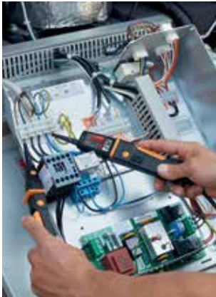
Kompresörde gerilim ölçümü
